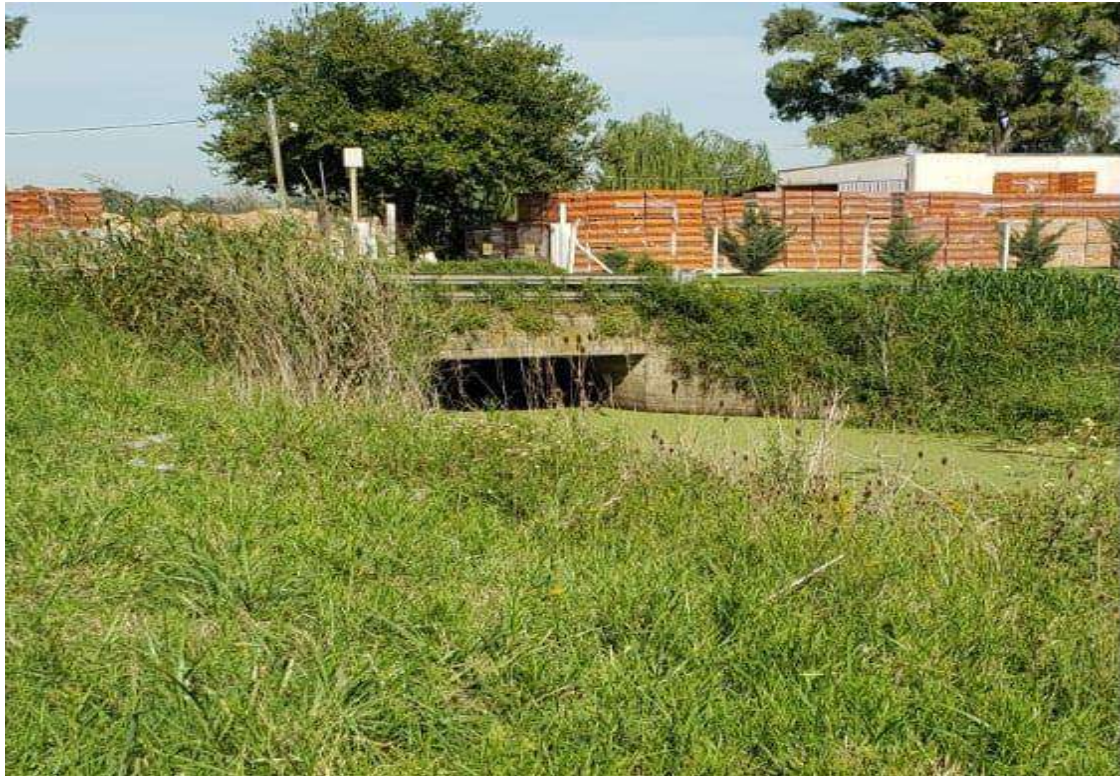
Alcantarilla Pr:18+120 aguas arriba
