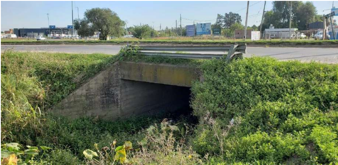
Alcantarilla Pr:16+040 aguas arriba
