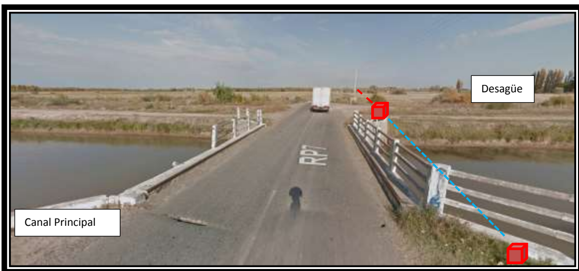
Foto 8: Canal principal y desagüe.
