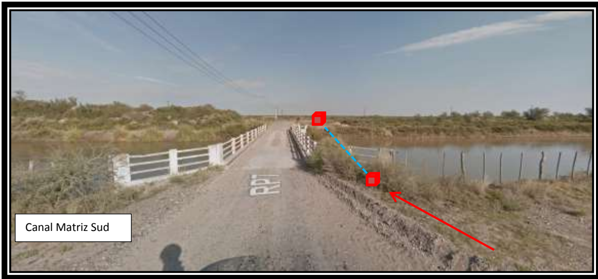
Foto 10 y 11: Puente del BS del RN de 50m y del Canal Matriz Sud de 20m.
