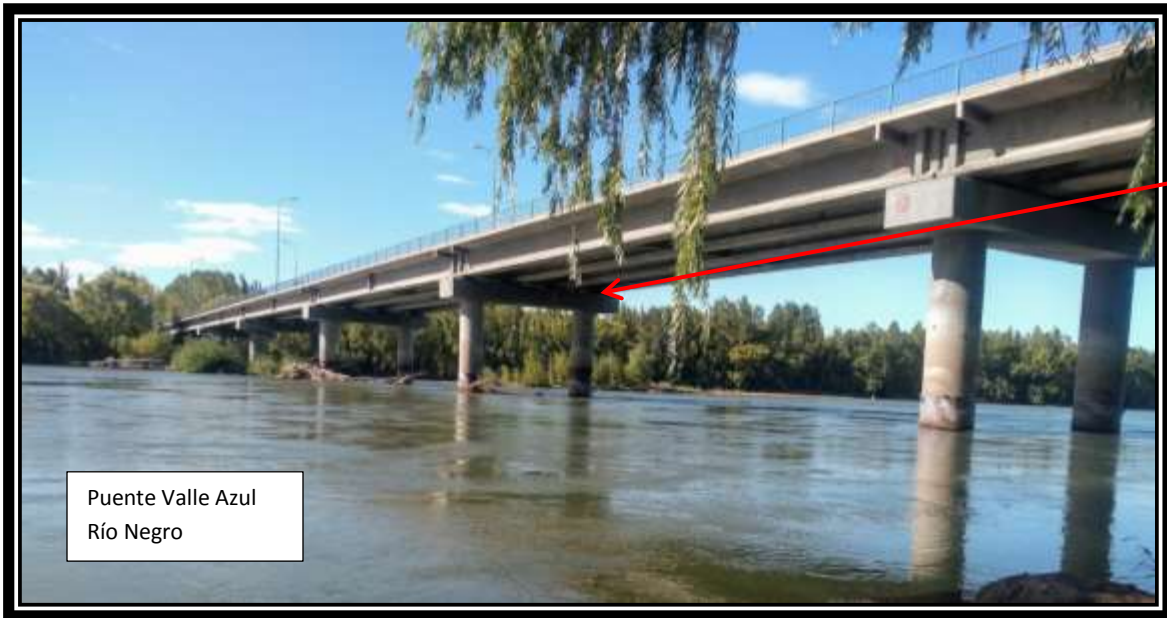
Foto 19 y 20: Camino Rural y y Puente de Valle Azul que cruza el Río Negro.
