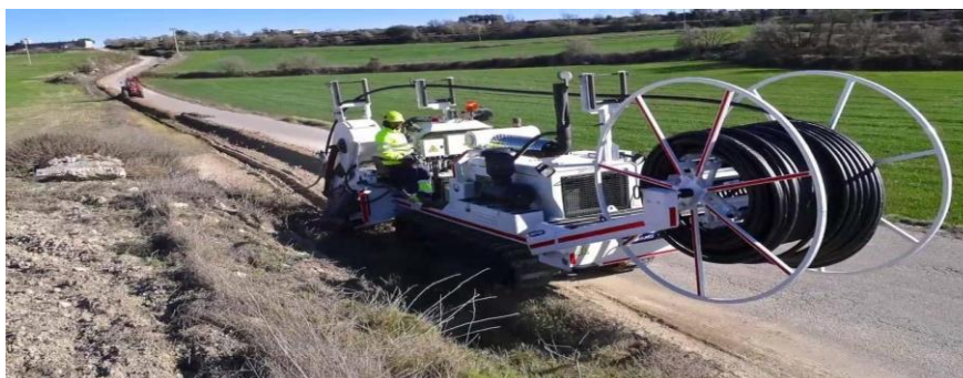
Figura 2: Metodología de tendido de FO automatizado
