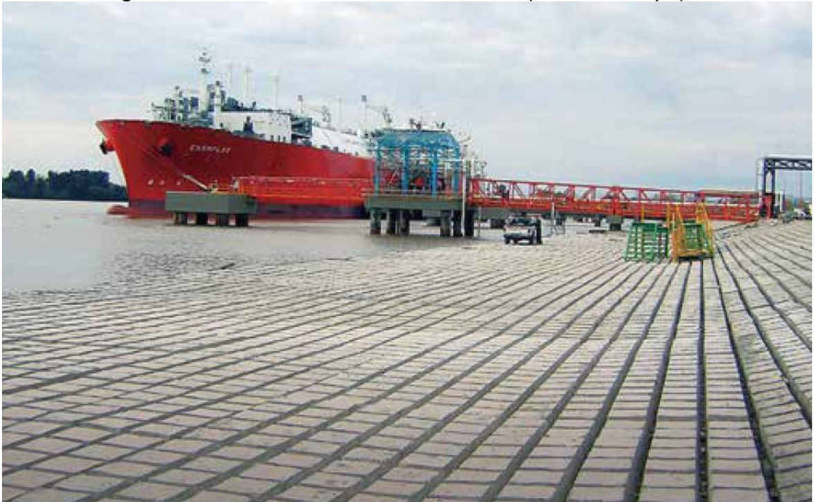
Figura 44: Protección con mantas flexibles (Fuente: Coripa)
