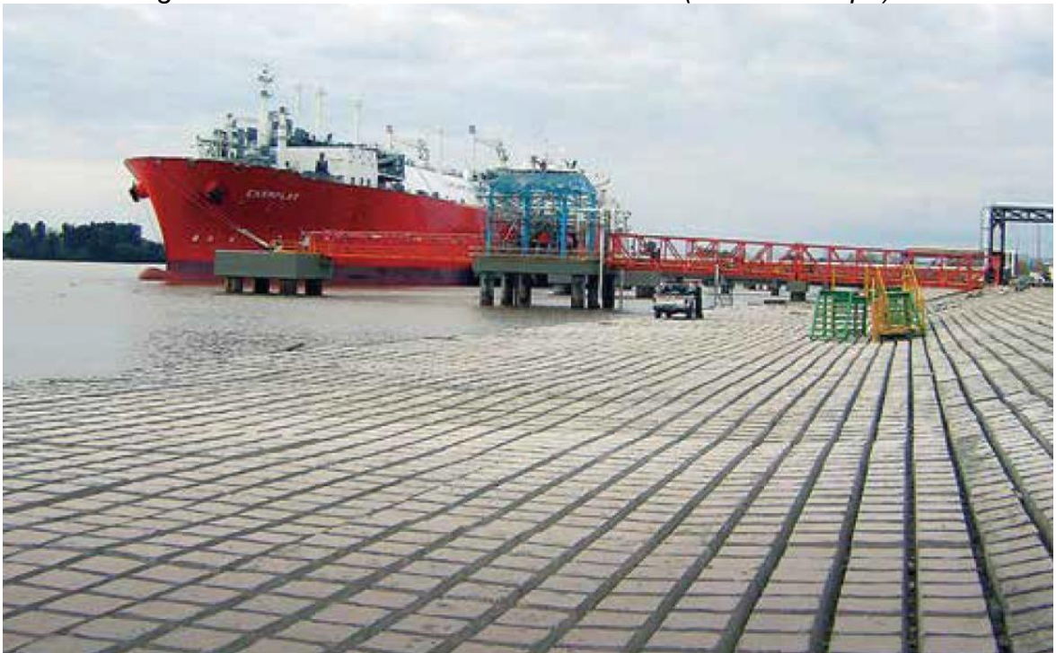
Figura 44: Protección con mantas flexibles (Fuente: Coripa)
