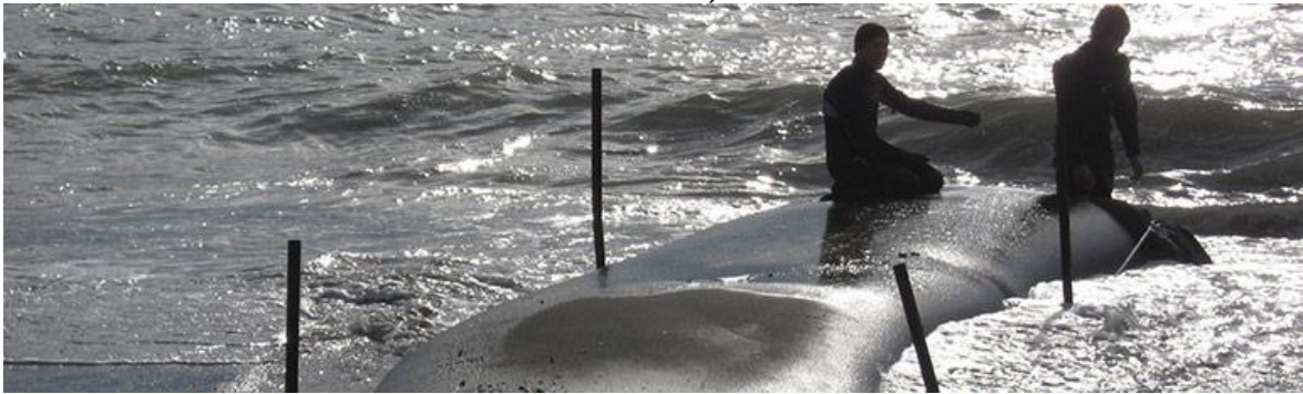
Figura 43: Tubo geotextil MacTubes utilizado como escollera (Fuente: Maccaferri)
