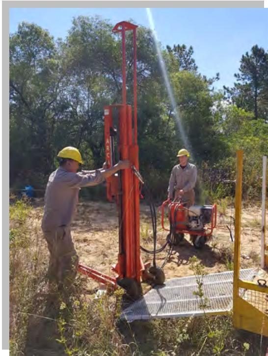
Fotografía N° 9: Ejecución de Sondeo SPT10- E5
