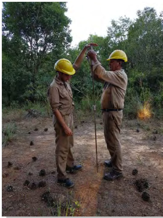
Fotografía N° 4 Ejecución de DCP- C4
