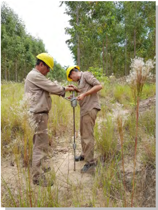
Fotografía N° 2: Ejecución de DCP- C2
