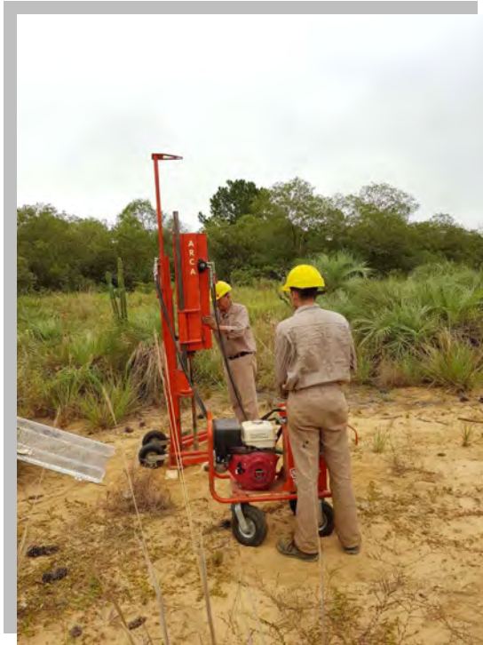
Fotografía N° 7: Ejecución de Sondeo SPT6- E1
