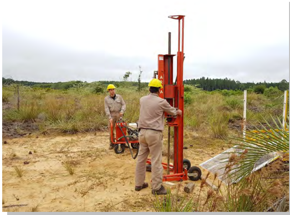
Fotografía N° 8: Ejecución de Sondeo SPT8- E 3
