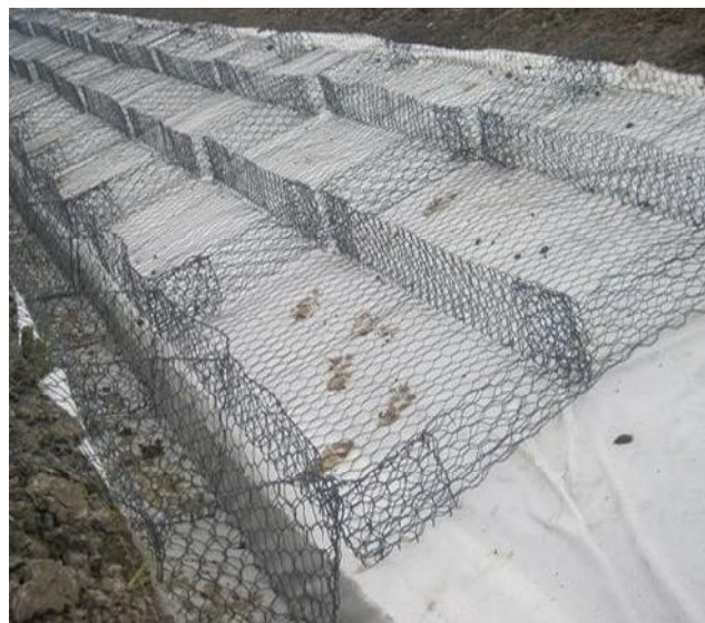
Ilustración 35: Estructura de Colchonetas y Gaviones Típico de Obra de Protección del Camino Costanero
