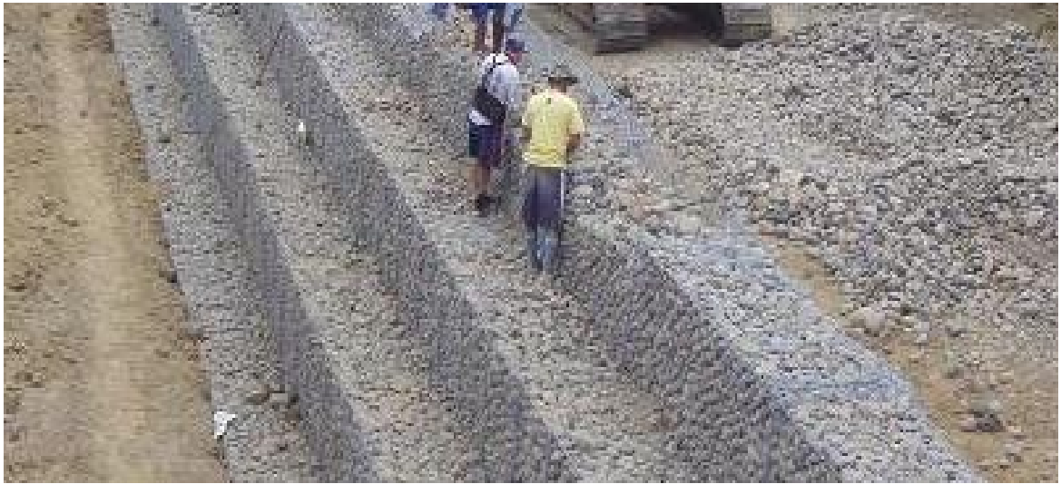
Ilustración 37: Esquema de Muro de Gaviones a Implantar como Defensas
