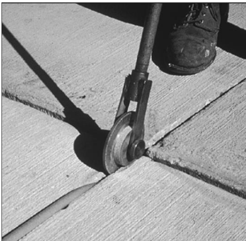
Instalación del Cordón de Respaldo
