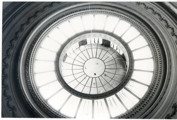
Foto n° 15: En proceso de intervención – año 1974
