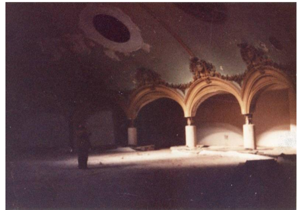
Foto n° 16: Incorporación del entrepiso
