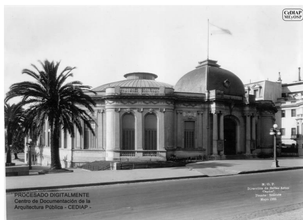
Foto n° 2: Fachada Posadas – Año 1935
