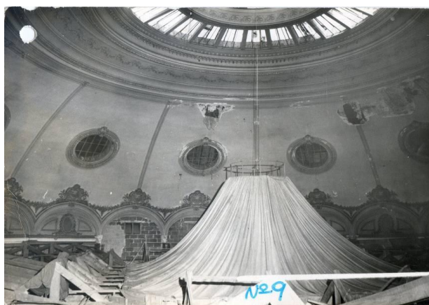
Foto n° 12: Detalle cúpula– año 1974
