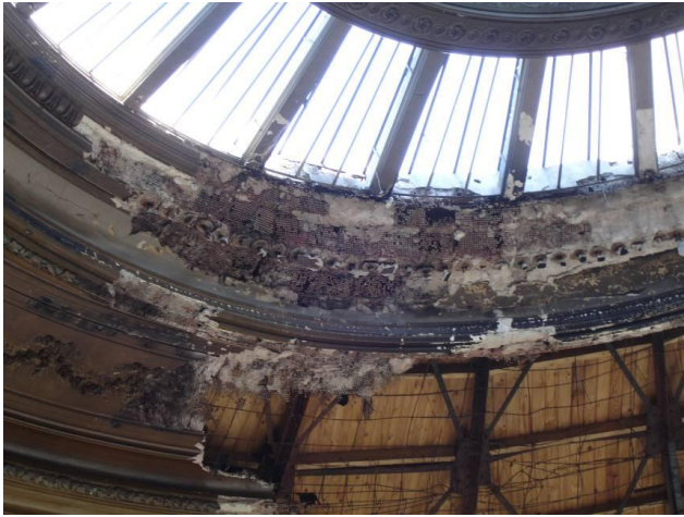
Foto n°21: Detalle cúpula y Foto n° 22: Detalle óculo cúpula después del incendio 1998
