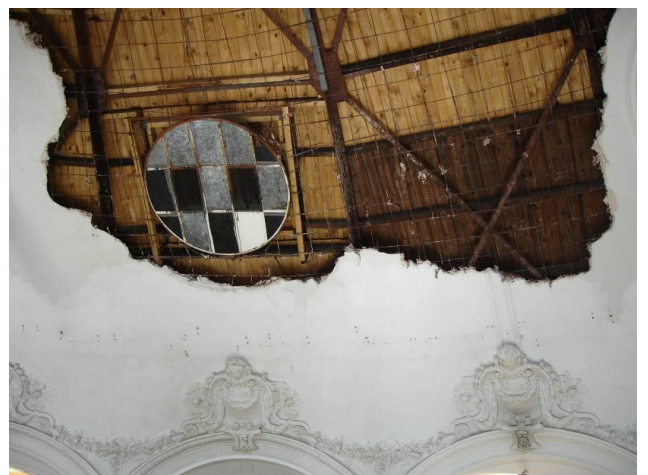
Foto n°21: Detalle cúpula y Foto n° 22: Detalle óculo cúpula después del incendio 1998
