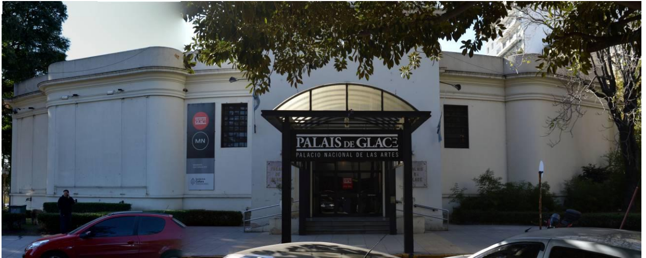
Foto n° 24: Fachada Posadas – Año 2015
