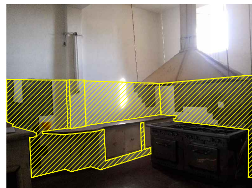
Demolición de revestimiento existente
