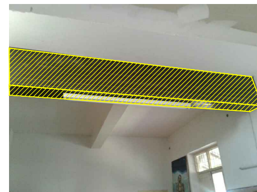
Demolición de revestimiento de viga
