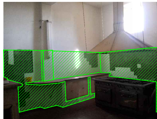
Colocación de nuevo revestimiento
