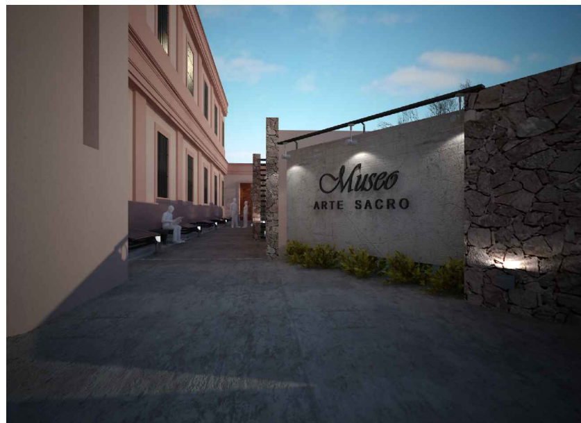
VISTA INGRESO POR CALLE SAN MARTIN
