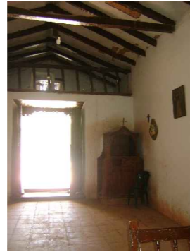
Refuerzos estructurales. Consolidación de estructura de techo
