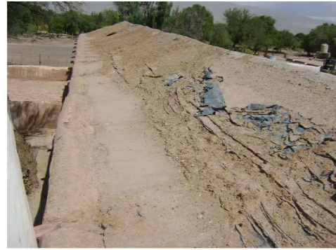
Capa de barro degradada x el clima
