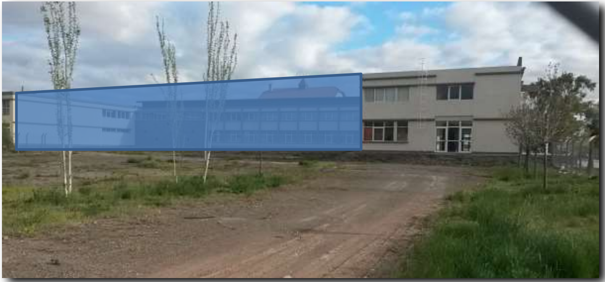
Foto N° 10: Vista hacia el noroeste del predio donde se instalará la Etapa 2 del Edificio Académico.
