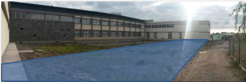
Foto N° 9: Predio de ampliación del Hospital Escuela- Vista noreste.
