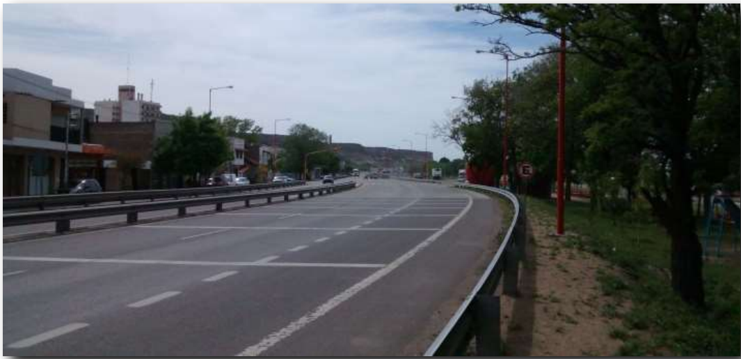
Foto N° 1: Acceso a la localidad por Ruta Nacional N° 22.
