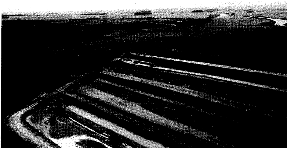
Recinto para deposito del material proveniente del dragado y de la excavación terrestre – Rio Salado Tramo III – Sector 1
