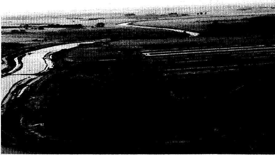
Vista recintos para material transportado en camiones y refulado por dragado – Rio Salado – Tramo III – Sector 1
