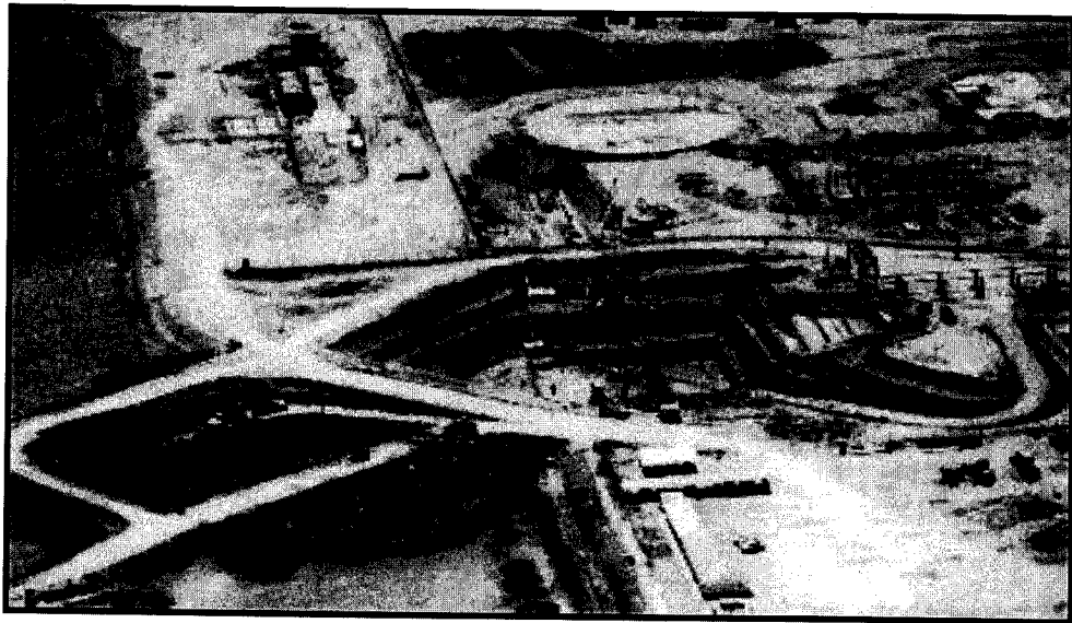
EXCAVACIÓN EN LA CASA DE BOMBAS DE REFRIGERACIÓN – CENTRAL ELECTRICA DE 2 x 310 Mw
