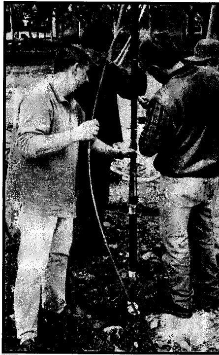
EJECUCIÓN DE ENSAYOS PRESIOMETRICOS
