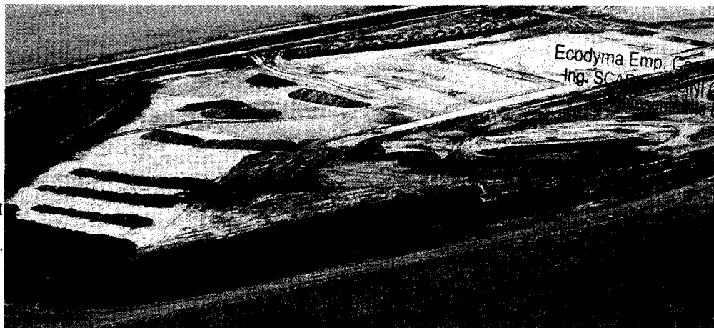
Trabajos de recubrimiento final con suelo orgánico - Río Salado - Tramo III - Sector 1
