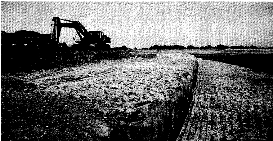
Excavación y perfilado de talud con retroexcavadora y carga directa sobre camión volcador – Rio Salado – Tramo III – Sector 1
