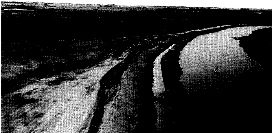
Excavación y perfilado de taludes previo al paso de la draga – Río Salado - Tramo III – Sector 1
