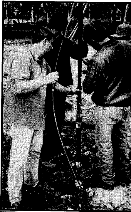
EJECUCIÓN DE ENSAYOS PRESIOMETRICOS
