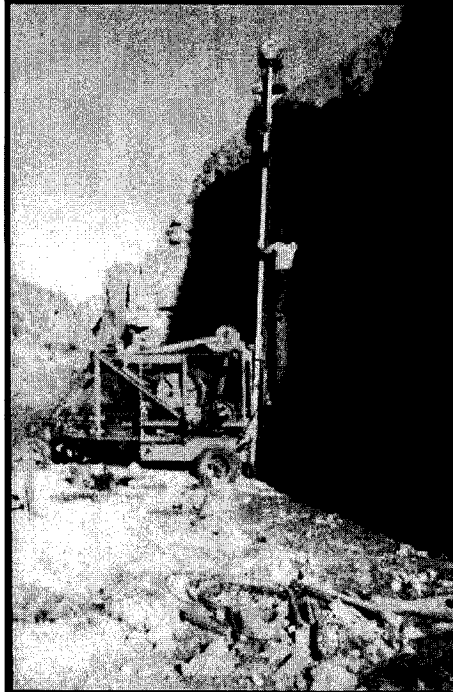
PERFORACIÓN DE ALUVIÓN “EL INFIERNILLO” – LA RIOJA
