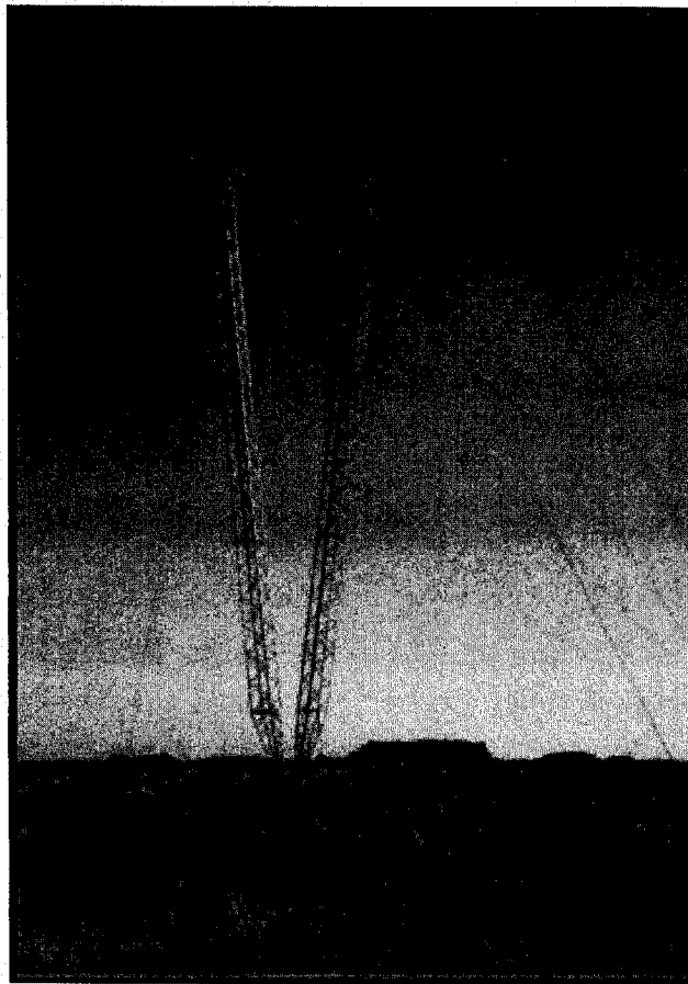
LINEA DE ALTA TENSION 500 Kv ALICURA - ABASTO
