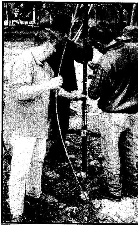
EJECUCIÓN DE ENSAYOS PRESIOMETRICOS
