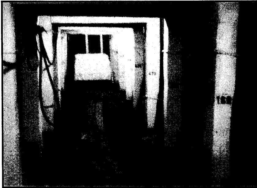
GALERIA DE INSPECCIÓN PARA DEFINIR LA FUNDACIÓN DE LA REPRESA DE PICHÍ PUCUN LEUFÚ
