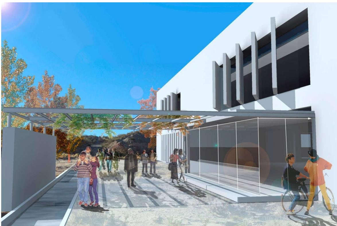
Se proyecta un edificio fuertemente enraizado a las condiciones climáticas del lugar. Cada una de sus fachadas con orientaciones diferentes va dando respuesta a cada una de las condicionantes. Es así que la fachada norte incorpora parasoles horizontales de distinta medida que protegen la entrada de sol directa al interior del edificio en los meses de estivales pero permiten la entrada de esta en épocas invernal.
